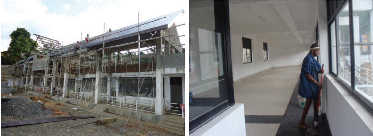
ඉදිවෙමින් පවතින තලවකැලේ නව බස් නැවතුම්පල
